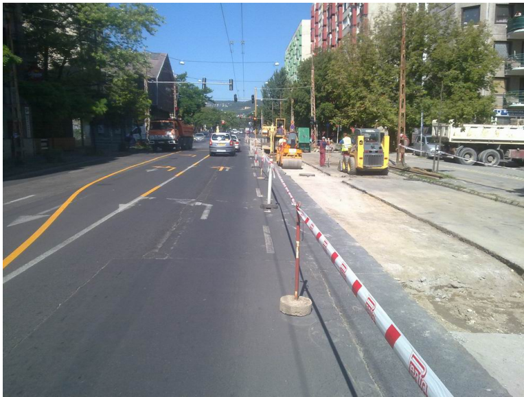
Fotó a csatorna építésről a Dráva utcában.
