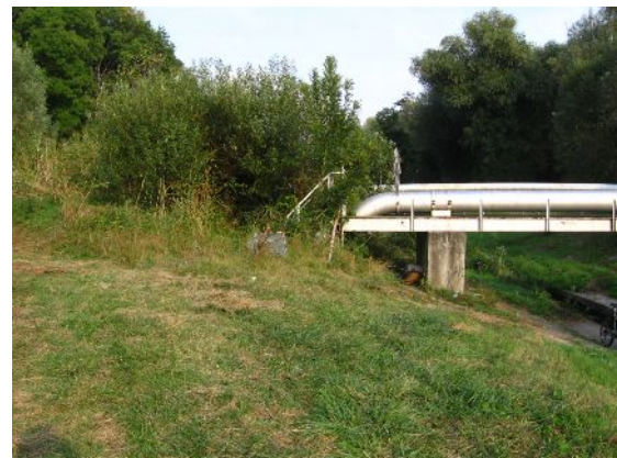
7. ábra Közműátvezetés a patak fölött (forrás: saját felvétel)
