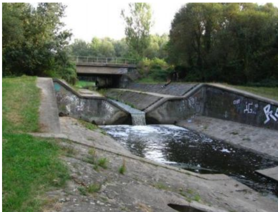
4. ábra A 80-as vasútvonal alatti műtárgy (forrás: saját felvétel)
