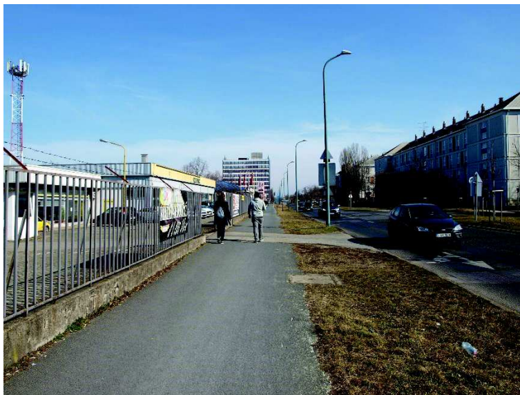
5. ábra: Kerékpárút szakasz a Mexikói úton kívül. A két forgalmi sáv megtartása esetén egyirányú kerékpáros közlekedés számára elválasztás alkalmazásával fenntartható létesítmény lehet. Javasolt a kismértékű szélesítés, amennyiben lehetséges (fasor telepítése vélhetően az itt elhelyezett gázvezeték miatt nem lehetséges).
