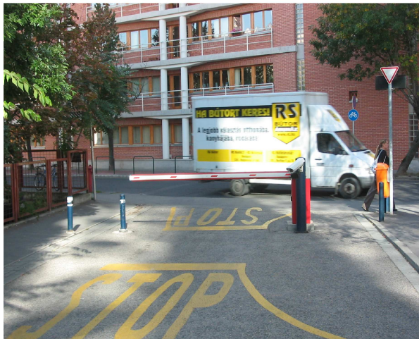
7. ábra A sorompótalp és a fal (itt járda) között elférnek a kerékpárosok
