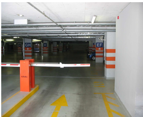
8. ábra A rövidebb sorompókar és a fal között elegendő szélesség maradt
